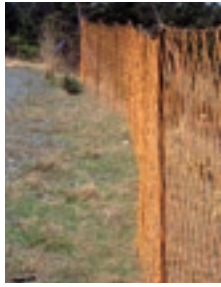
⑤ ネットを使用した 防護柵の一例
